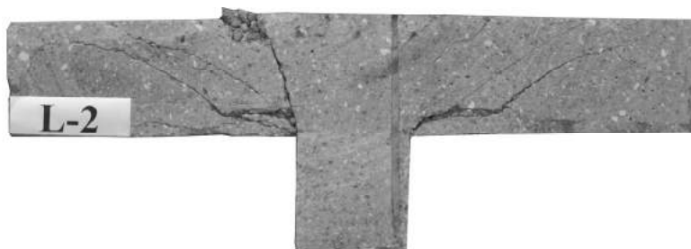
Rys. 4. Przekrój modelu L-2 z widocznymi rysami omijającymi zbrojenie poprzeczne
