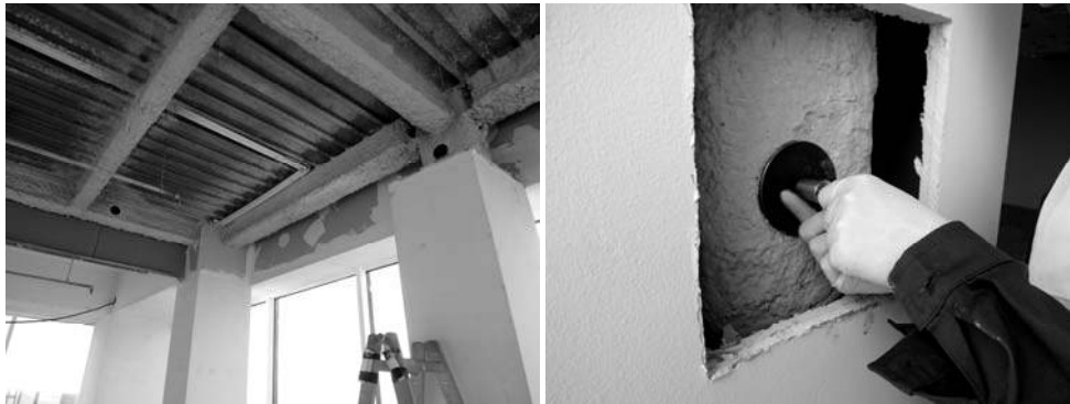
Rys. 1. Zabezpieczona konstrukcja stalowej (po lewej) i przygotowanie do badania przyczepności (po prawej), archiwum ITB
