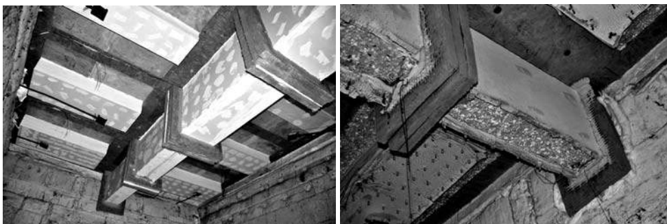
Rys. 1. Widok elementów próbnych płytowych i belkowych przed badaniem (po lewej) i elementu belkowego po badaniu (po prawej)
