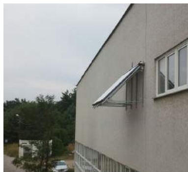
Miejsce i sposób montażu kolektorów próżniowych
