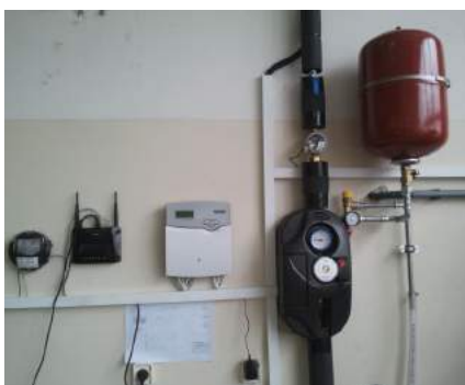
Sterownik układu, moduł rejestracji danych, moduł transmisji danych oraz grupy pompowej wraz z grupą bezpieczeństwa obiegu solarnego
