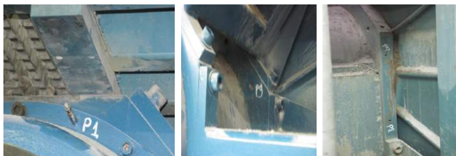
Rys. 7.3. Mocowanie czujnika drgań w wybranych punktach (1, 7, 8, 9) odbioru sygnału
