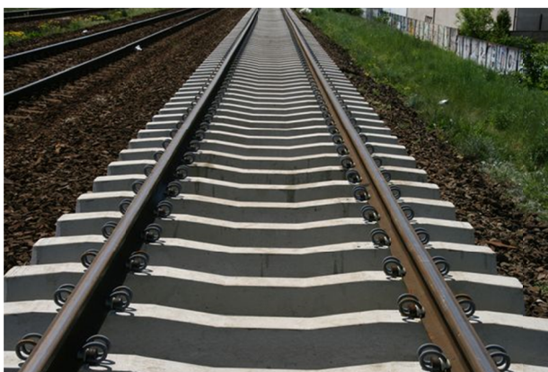
Rys. 1. Przykład podkładu strunobetonowego PS-94 z wytwórni WPS S.A. [10]
