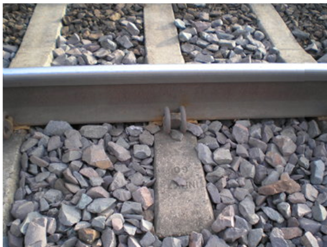
Rys. 2. Przykład podkładu strunobetonowego INBK-7 [7]
