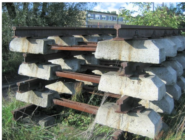
Rys. 3. Przykład żelbetowego podkładu BI-3 [9]
