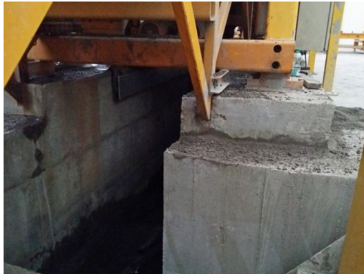
Fot. 1. Dwudzielny monolityczny blok fundamentowy (fot. Ł. Mrozik)
