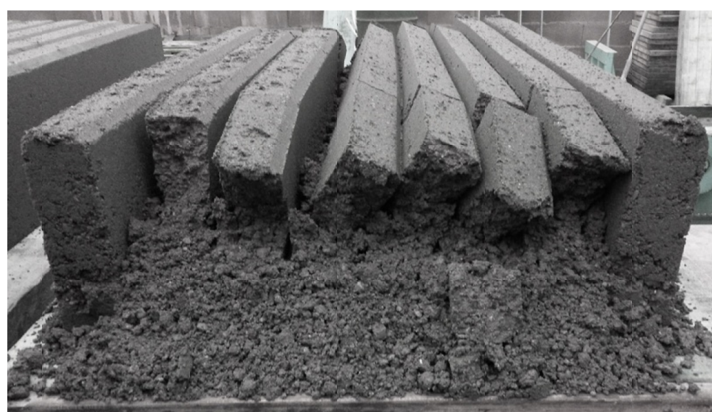
Fot. 4. Dezintegracja świeżych obrzeży chodnikowych (fot. Ł. Mrozik)
