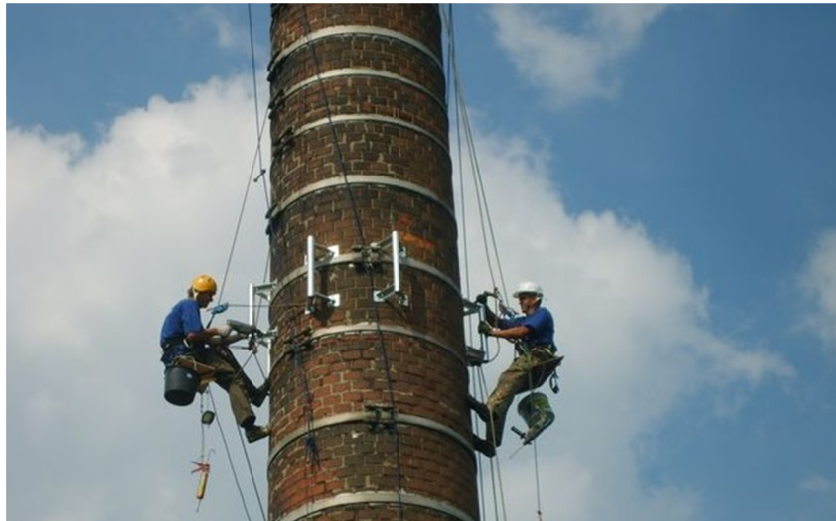
Rys. 11. Montaż masztów antenowych na kominie przez grupę alpinistów źródło: fot. www.pracealpinistyczne.com
