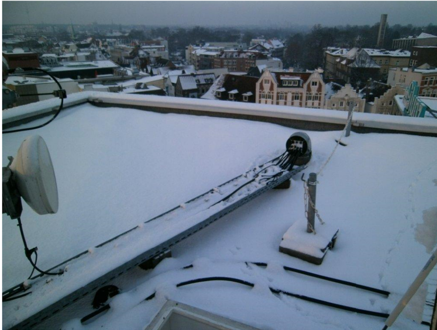
Rys. 12. Przejście na kabły typu Roxtec w konstrukcji stropodachu, źródło: Infra.tel
