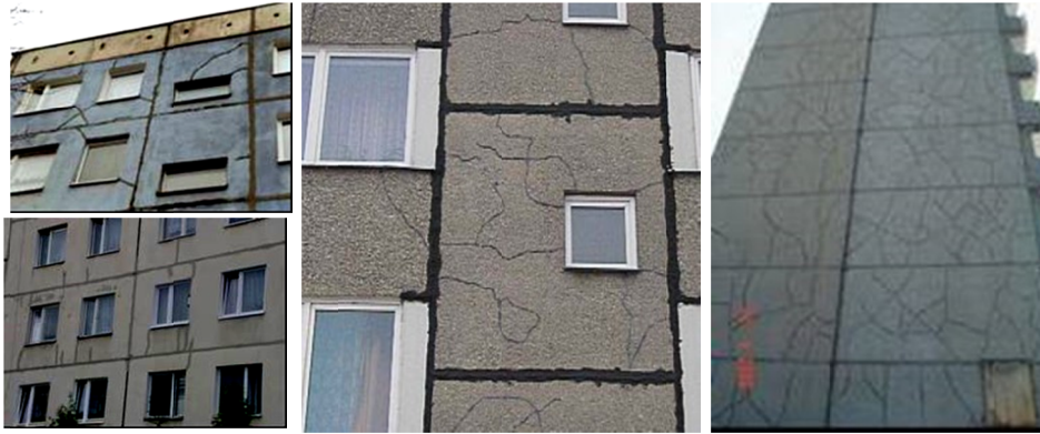
Rys. 13. Przykłady charakterystycznych zarysowań w warstwie fakturowej
