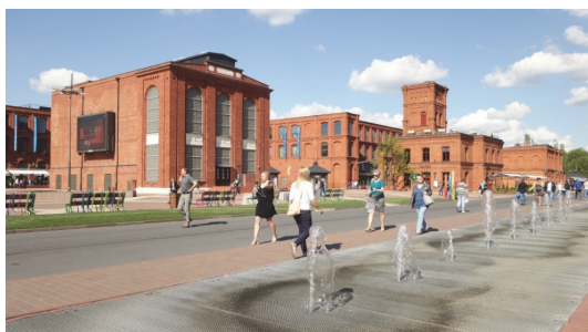
Rys. 2. Komercyjny sukces przestrzeni handlowej oczyszczonej z historycznej tkanki wewnętrznej (liczne wyburzenia z zachowaniem fasad) i oryginalnego zagospodarowania terenu. Manufaktura w Łodzi (źródło: fot. autor, 2015)
