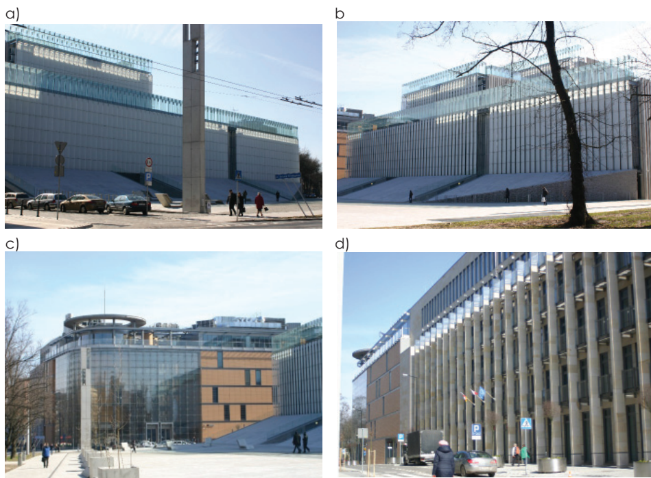
Rys. 5. Plac Teatralny w Lublinie: a) Plac teatralny od strony obiektu Lubelskie Centrum Kultury, b) Plac Teatralny przed Centrum Spotkań Kultur, c) Pierzeja Placu Teatralnego – Lubelskie Centrum d) Droga serwisowa do Placu Teatralnego, wzdłuż Elewacji Lubelskiego Centrum Kultury [fot. autor]
