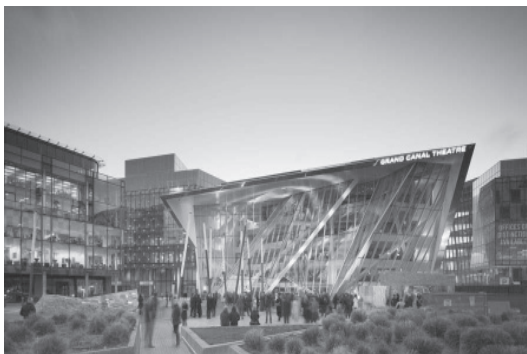
Rys. 1. Plac Grand Canal przed teatrem Libeskinda [fot. autor]
