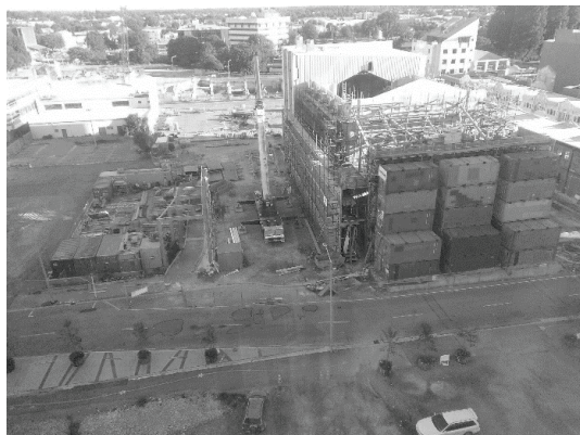
Rys. 1. Isaac Theatre Royal podczas odbudowy, kontenery zabezpieczają ulicę Gloucester przed ewentualnymi skutkami zawalenia się elewacji frontowej, 2013 r. [fot. autor]
