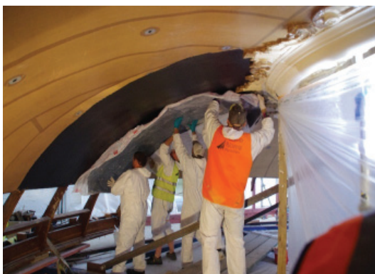
Rys. 4. Wzmacnianie kopuły matami węglowymi od strony podniebienia, 2013 r. [fot. autor]
