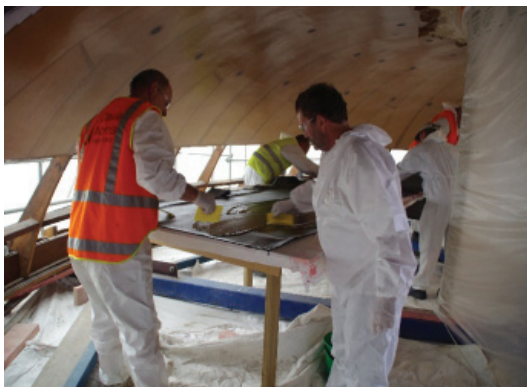
Rys. 3. Przygotowywanie mat węglowych przed wzmocnieniem kopuły, 2013 r. [fot. autor]
