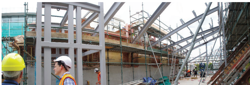
Rys. 2. Połączenie historycznej elewacji z konstrukcją stalową i żelbetową, 2013 r. [fot. autor]
