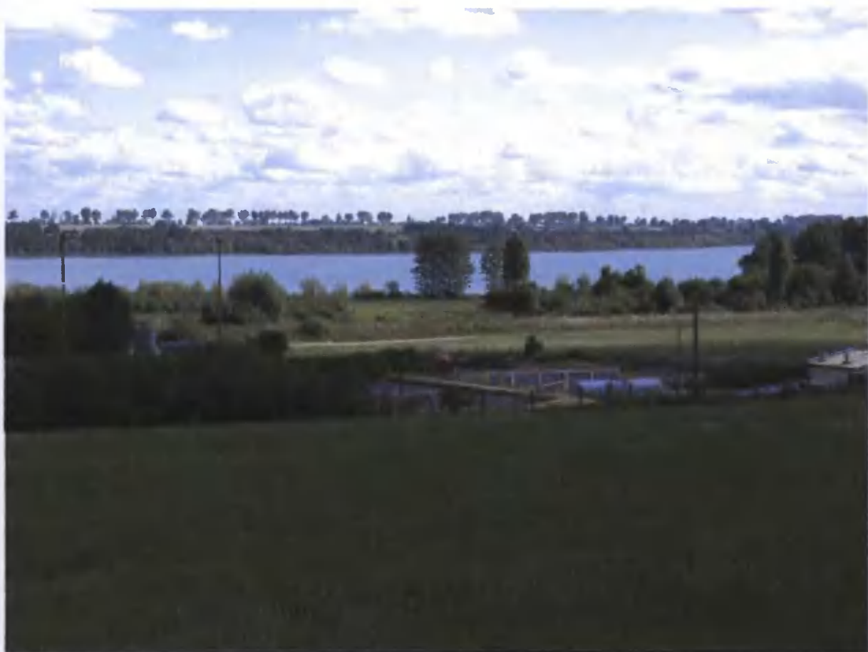
Fot. 5.3. Widok na oczyszczalnię (w tle Jezioro Żnińskie Duże) (fot. M. Stanek)
