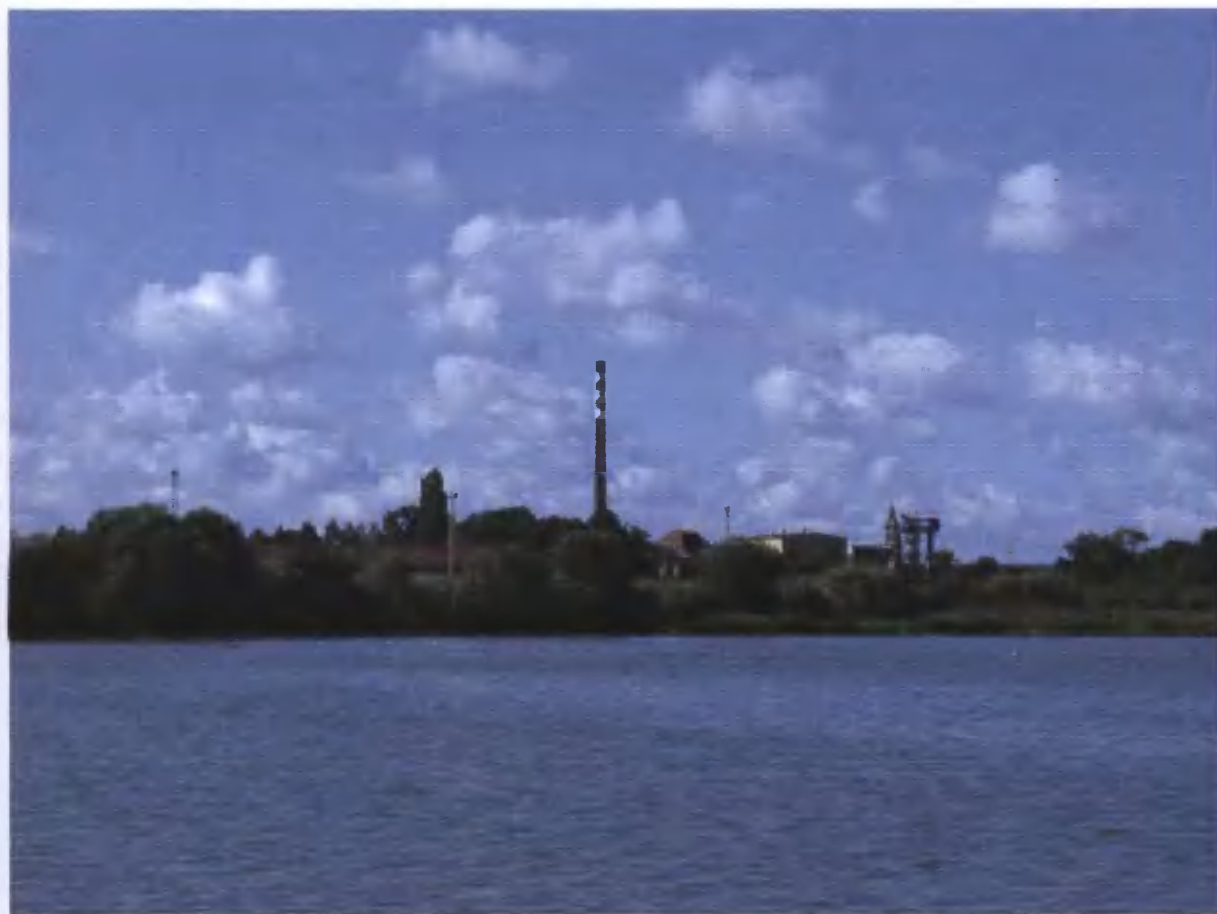
Fot. 5.2. Widok na cukrownię od strony jeziora (fot. M. Stanek)
