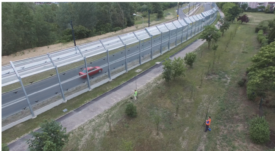
Rys. 6. Widok lokalizacji punktów pomiarowych (fot. K. Pietrzak)
