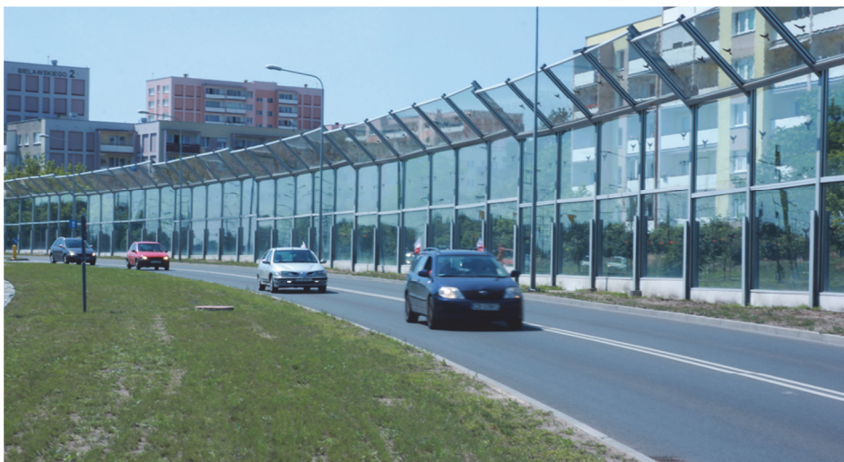
Rys. 4. Widok ekranów akustycznych przy ulicy Akademickiej w Bydgoszczy (fot. A. Augustyńska)
