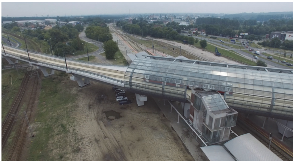
Rys. 3. Widok węzła Bydgoszcz Wschód z lotu ptaka (fot. K. Pietrzak)
