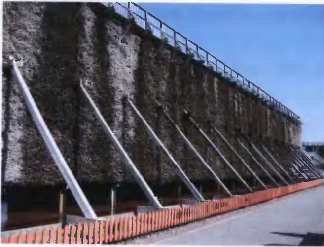
Rys. 7 Widok na konstrukcję ścian bocznych tężni
