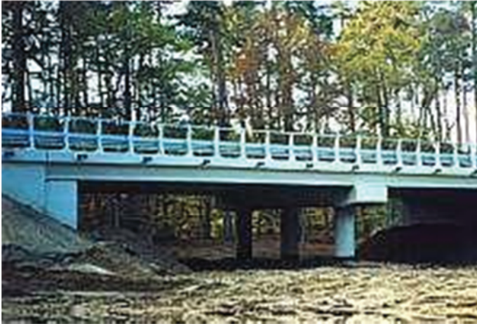
Rys. 6. Przejście pod estakadą. Zbyt mała wysokość przejścia, brak odpowiedniego zagospodarowania (źródło: http://siskom.waw.pl/nauka-srodowisko.htm#9 )
