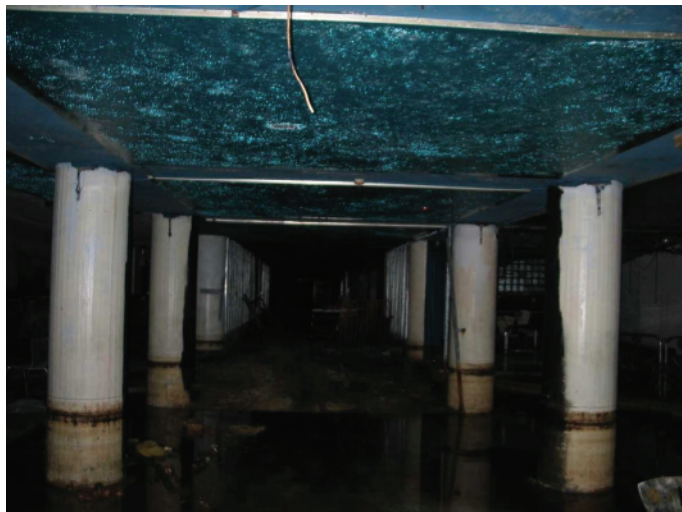
Rys. 2. Widok ogólny głównej sali schronu z układem słupów podpierających strop Fig. 2. View of the main hall of the shelter with pillars supporting slab deck
