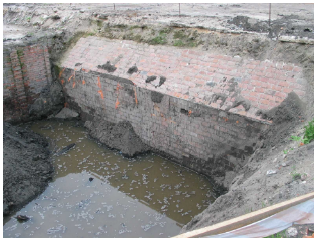
Rys. 4. Widok fragmentu ściany podłużnej schronu i czerpni powietrza
