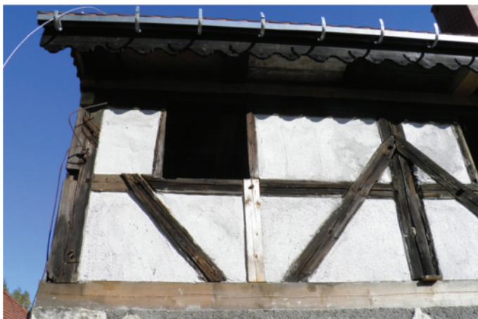
Rys. 4. Ucięty fragment zastrzału. Słup po prawej stronie niewłaściwie oparty na nowej podwalinie za pomocą drewnianej podkładki
