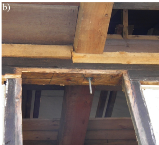
Rys. 8. Niewłaściwie wykonane połączenia elementów ściany
