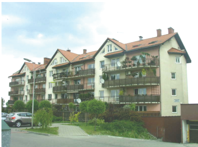
Rys. 1. Budynek przy ul. Łokietka nr 10 od strony zachodniej
