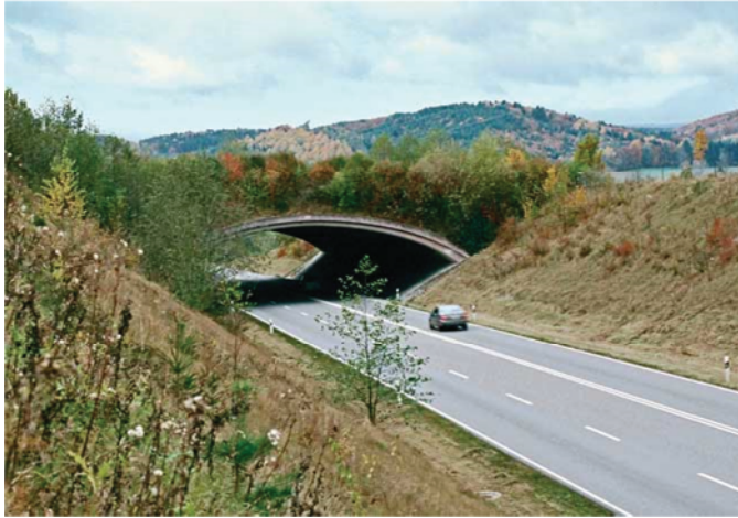
Rys. 5. Przejście górne (źródło: http://pracownia.org.pl/przejscia-dla-zwierzat )
