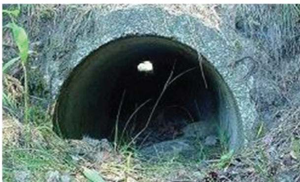
Rys. 2. Przepust dla drobnych ssaków – przejście dolne (źródło: http://siskom.waw.pl/nauka-srodowisko.htm#9 )
