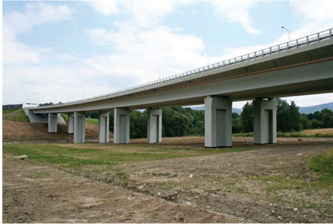
Rys. 7. Przejście dolne pod estakadą. Zwraca się uwagę na ubogie zagospodarowanie przestrzeni pod pomostem estakady (źródło: http://pracownia.org.pl/przejscia-dla-zwierzat )
