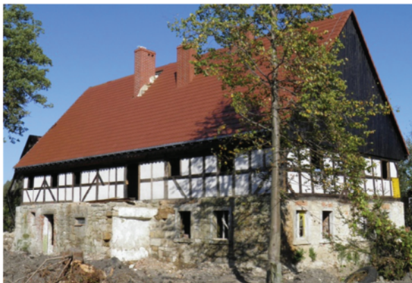
Rys. 2. Widok ogólny budynku, widok od strony pld.-zach.
