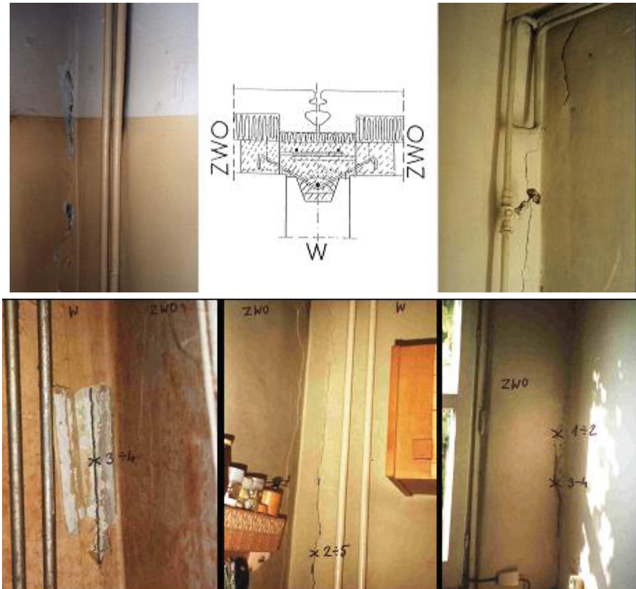
Rys. 4. Przykłady zarysowania złączy ZWO-W-ZWO [14]
