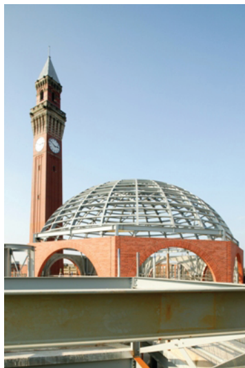
Rys. 9. Przekrycie kopułą sali koncertowej na Uniwersytecie Birmingham
