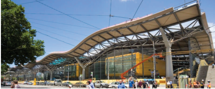
Rys. 16. Przekrycie peronów na dworcu kolejowym w Melbourne
