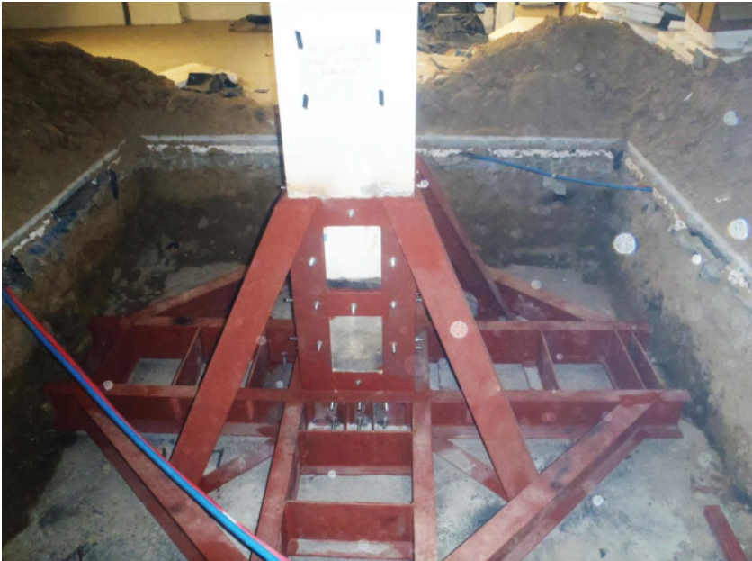
Rys. 7. Realizacja wzmocnienia słupów silnie obciążonych
