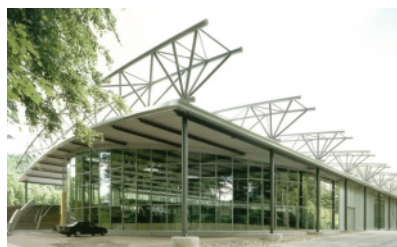
Rys. 3. Przekrycie hali sportowej [25]
