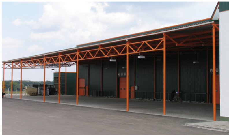
Rys. 1. Wykonana konstrukcja wiaty (2006 r.)
