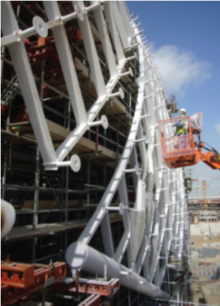
Rys. 10. Powłoka siatkowa z obrotowymi rombowego kształtu szybami osłaniająca budynek Yas Island Marina Hotel w Abu Dhabi
