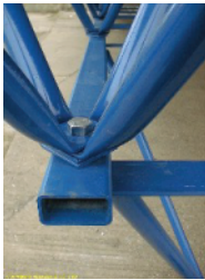
System połączenia Conder-Harley przy zachowaniu ciągłych pasów (zdjęcie John Chilton) [3]
