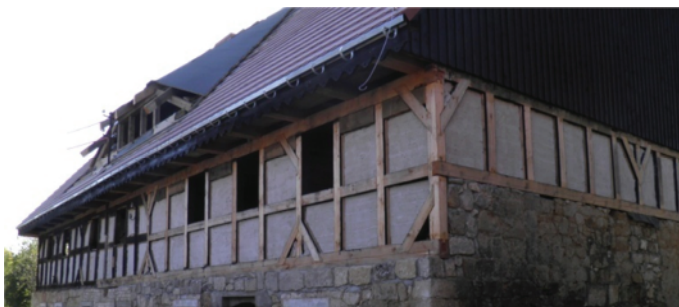
Rys. 3. Ściany pierwszego piętra, widok od strony północno-wschodniej
