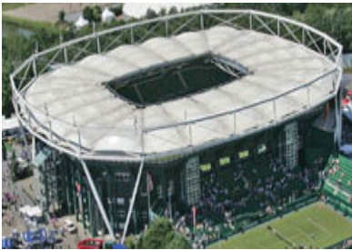
Rys. 25. Przekrycie stadionu tenisowego w Halle
