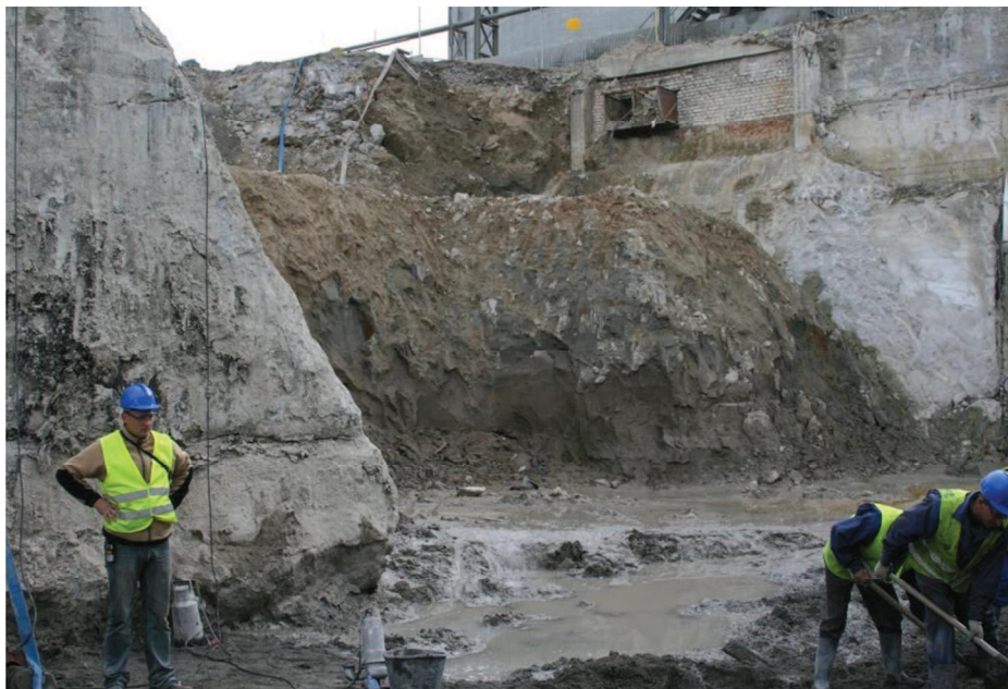
Fot. 4. Etap I realizacji nasypu poziom – 10,0 m p.p.t.
