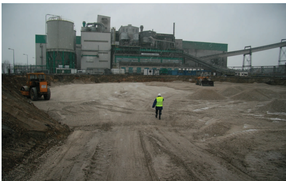
Fot. 11. Widok poligonu – etap III. Widok wbudowywania kolejnej warstwy
