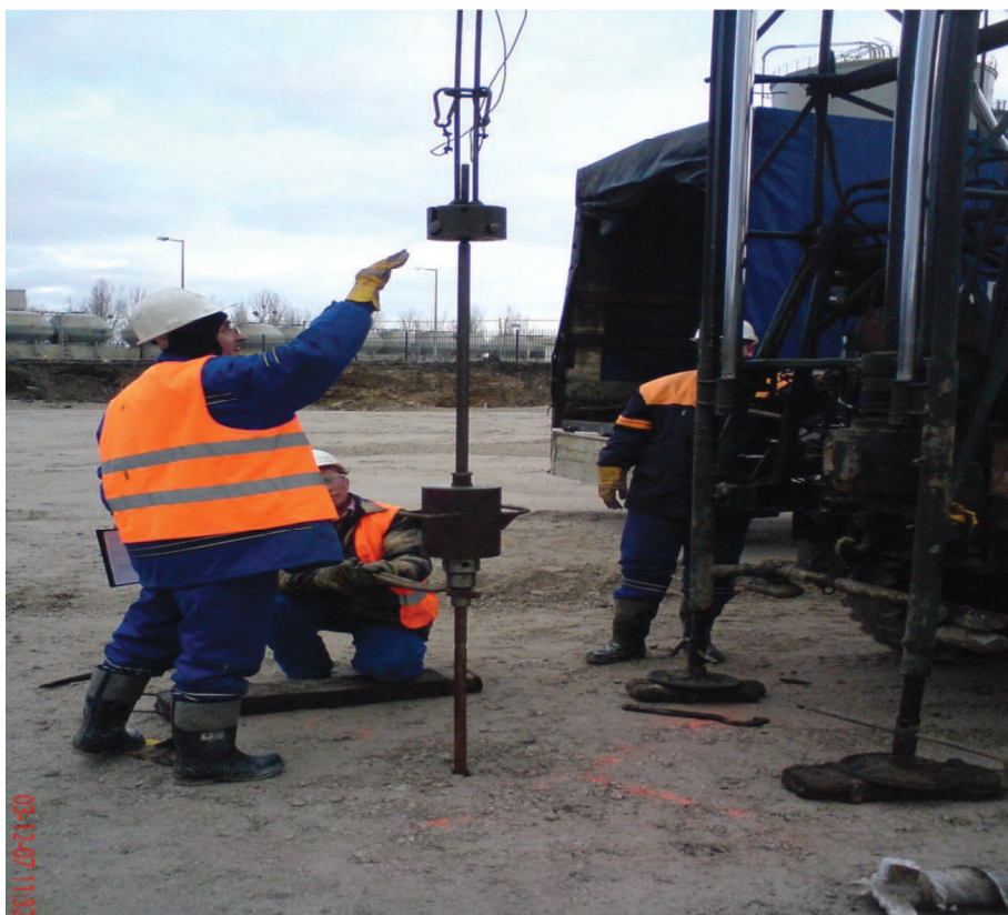
Fot. 15. Sondowanie sondą ciężką typu DPSH w nasypie budowlanym
