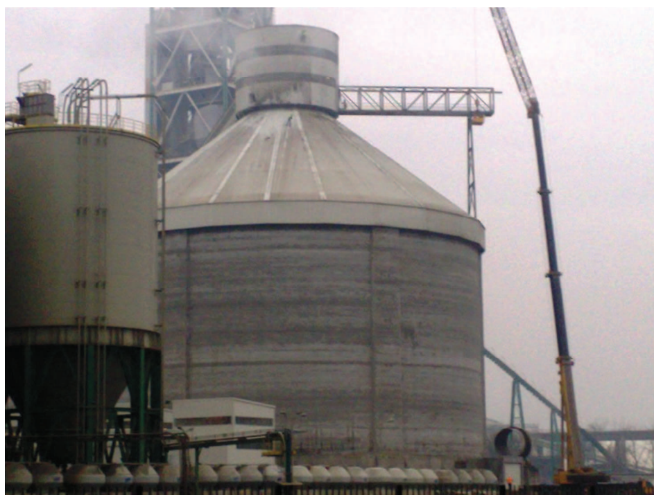
Fot. 18. Widok silosu na 200 tys. ton klinkieru
