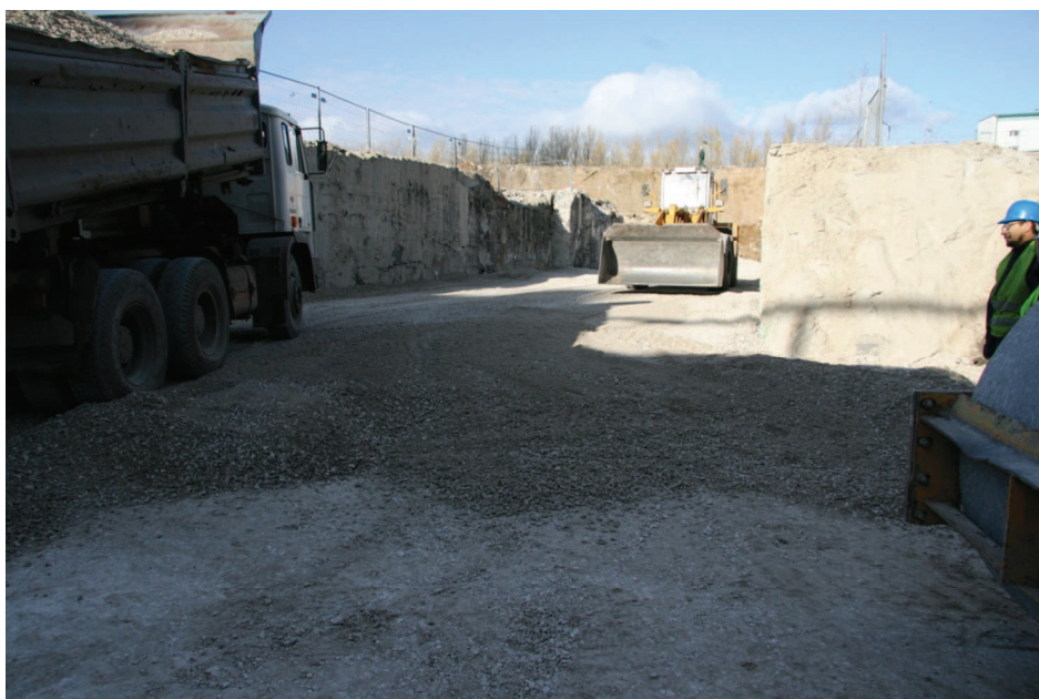
Fot. 7. Poligon doświadczalny – etap I. Układanie kolejnej warstwy kruszywa
