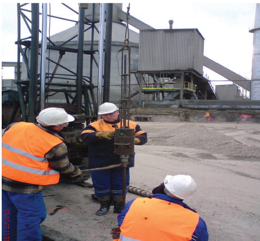
Fot. 14. Sondowanie sondą ciężką typu DPSH nasypu budowlanego – weryfikacja stanu zagęszczenia
