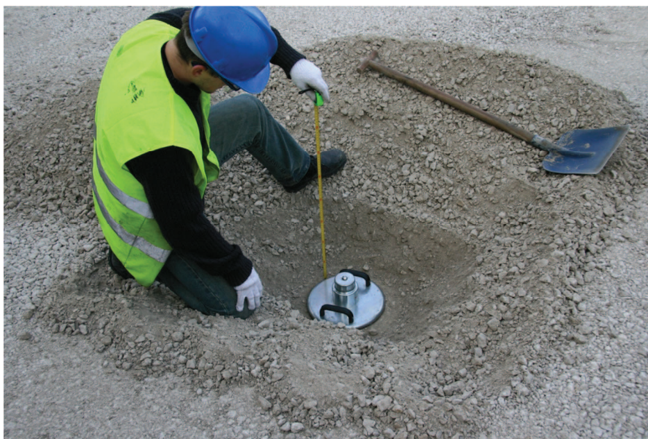
Fot. 10. Widok poligonu – etap III. Przygotowanie do badania wstecznego poziom – 0,60 m
