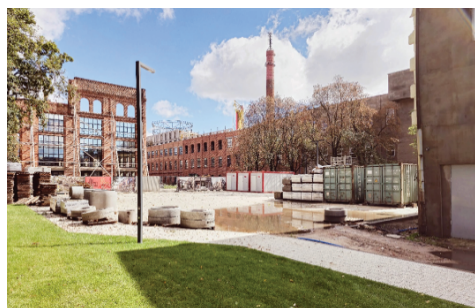
Rys. 3. Proces rewitalizacji fasady budynków kompleksu Widzewskiej Manufaktury – fragment elewacji w trakcie odnowy (fot. autorka, 15.09.2024)
