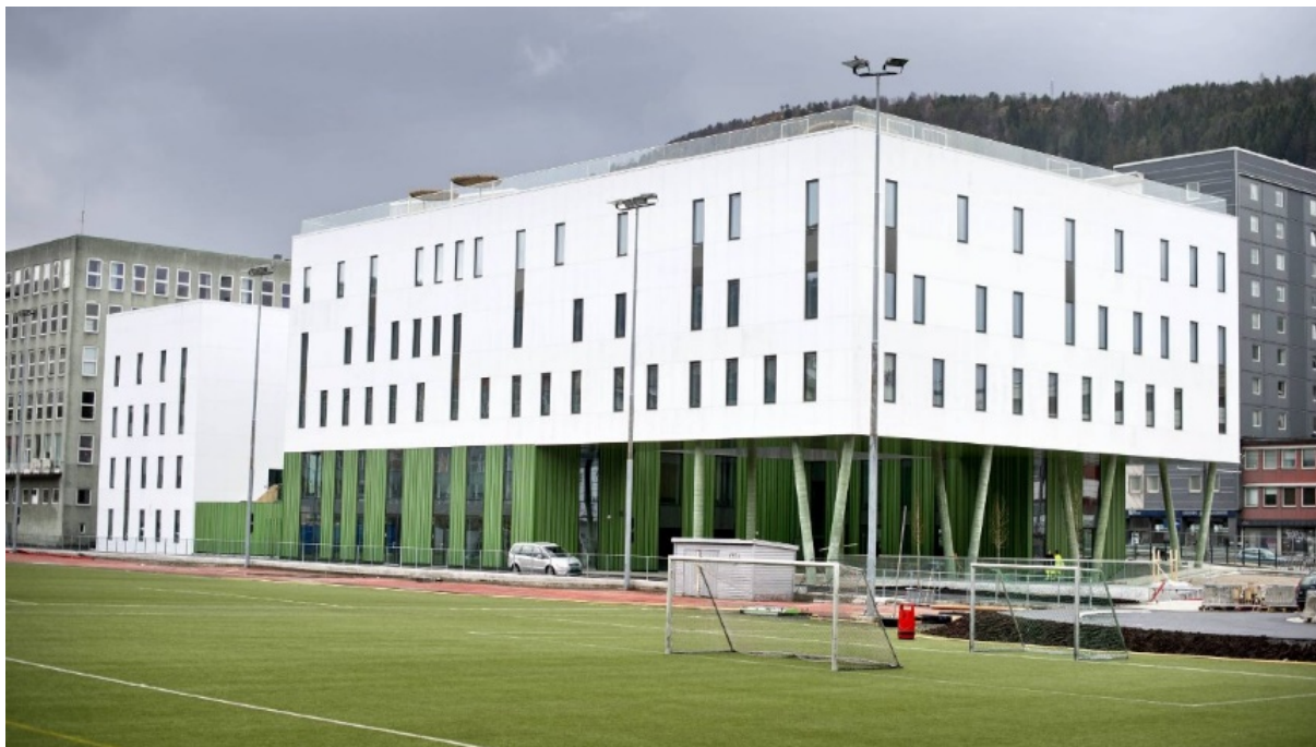
Ryc. 20. Kronstad Psychiatric Hospital, widok budynku od strony boiska pobliskiej szkoły
