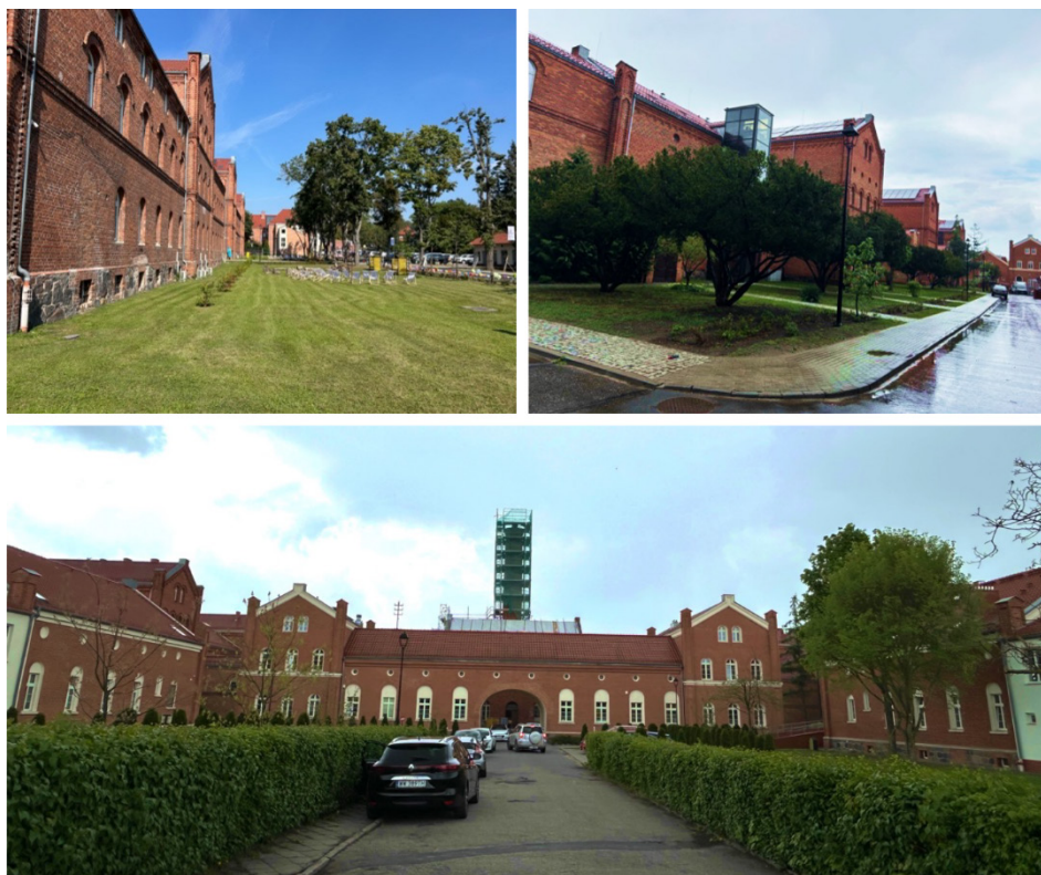
Ryc. 1. Zagospodarowanie terenu otaczającego zespół budynków szpitala w Świeciu, stan na wiosnę 2025 r., przed przystąpieniem do zmian kompozycyjnych i funkcjonalnych terenu Źródło: zdjęcia autorki.
