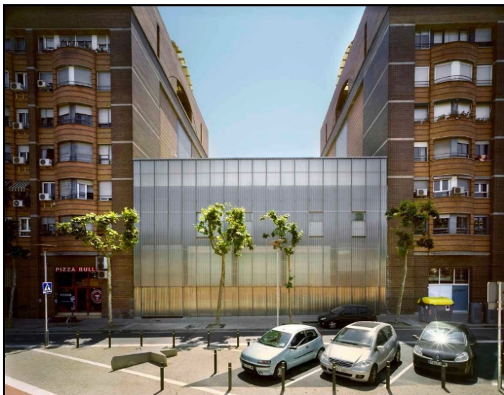
Ryc. 24. Residencia Y Centro De Día Para Disminuidos Psíquicos – widok od strony ulicy
