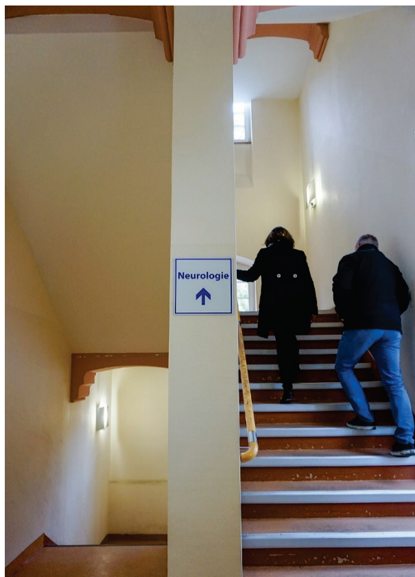
Il. 4.108. Ueckermünde, Provinzial-Irrenanstalt Ueckermünde – bezpieczne schody ze ścianą (fot. autorka, 2019 r.)
