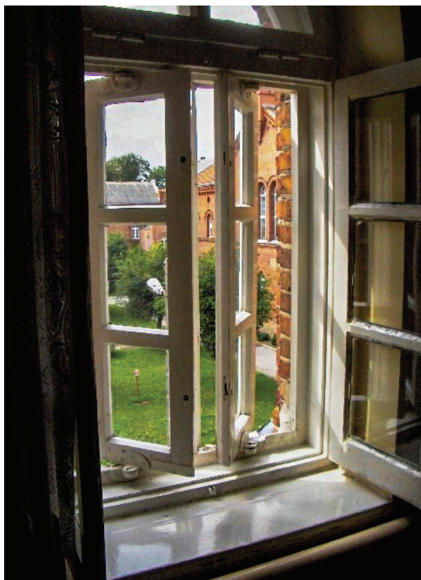
Il. 4.107. Świecie, Provinzial-Irrenanstalt in Schwetz – bezpieczne okno (fot. autorka, 2010 r.)
