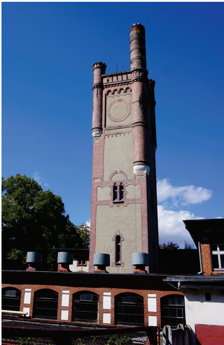
Il. 4.69. Trzebiatów, Provinzialheilanstalt zu Treptow a. Rega – wieża ciśnień z kominem kotłowni (fot. autorka, 2019 r.)
