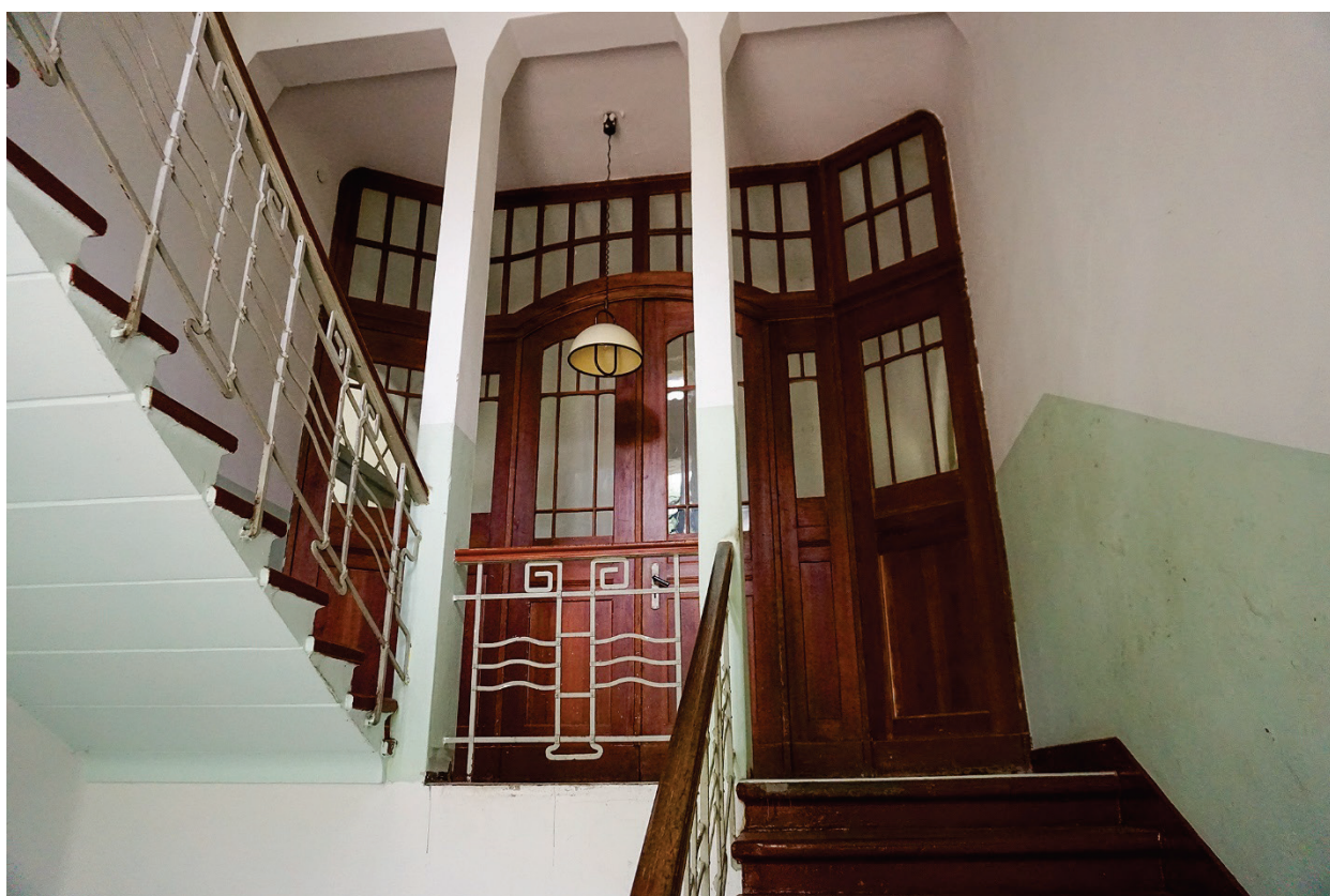
Il. 4.109. Ueckermünde, Provinzial-Irrenanstalt Ueckermünde – klatka schodowa w pensjonacie z podwieszonymi schodami ognioodpornymi (fot. autorka, 2019 r.)
