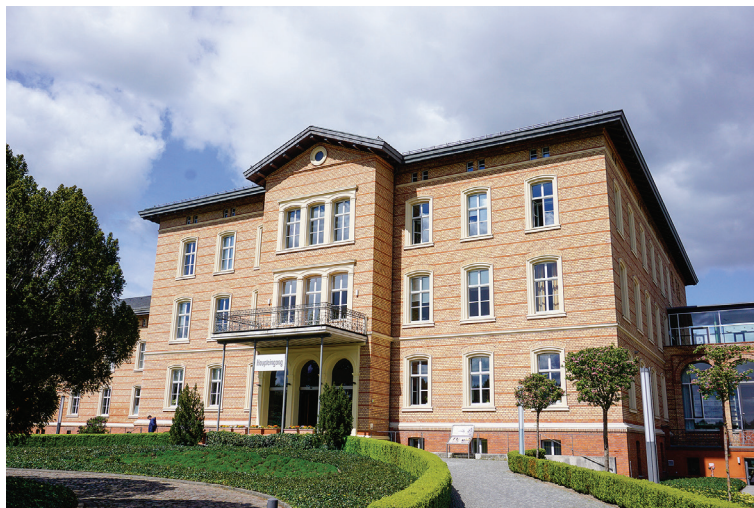
Il. 4.85. Eberswalde, Die Provinzial-Irrenanstalt zu Neustadt-Eberswalde – budynek administracji (fot. autorka, 2019 r.)
