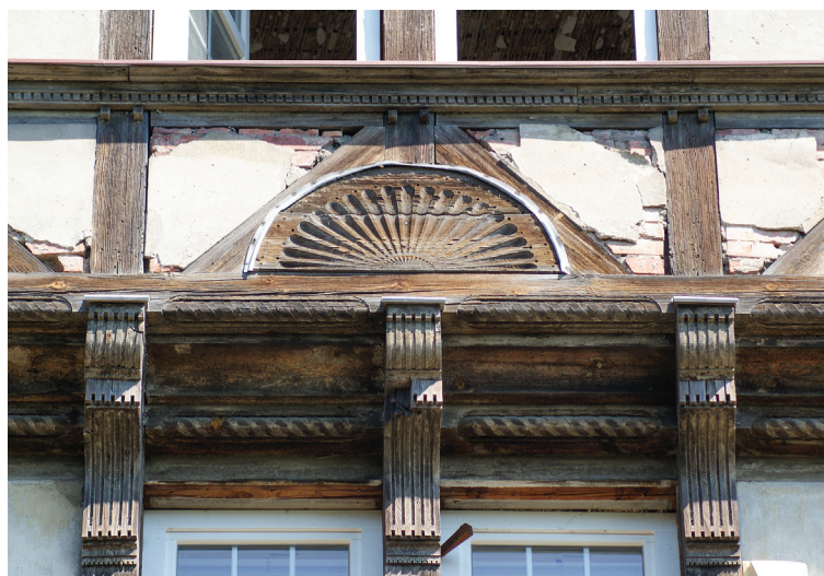
Il. 4.98. Świecie, Westpreussischen Provinzial-Irrenanstalt in Schwetz – budynek dla pracowników, z okresu rozbudowy – detal (fot. autorka, 2018 r.)
