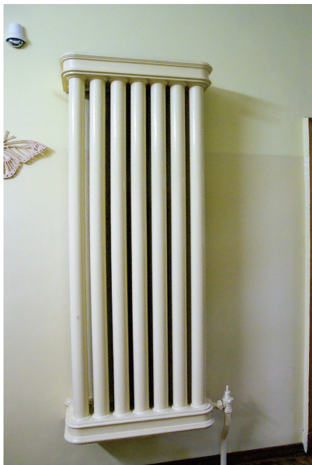
Il. 4.104. Dziekanka, Provinzial-Irrenanstalt Dziekanka – kaloryfer systemu ogrzewania parowego (fot. autorka, 2017 r.)
