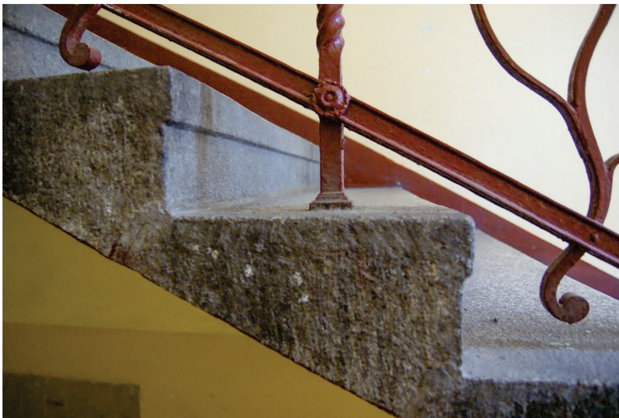
Il. 4.110. Obrzyce, Provinzial-Irrenanstalt Obrawalde bei Meseritz – bezpieczne schody podwieszane, kamienne, ognioodporne (fot. autorka, 2018 r.)
