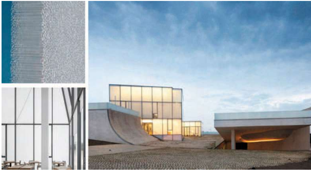
Rys. 1. Budynek Cite de l'Océan et du Surf, Steven Holl Architects: a) izolacja transparentna Kapilux [10], b) fragment wnętrza [11], c) budynek z zewnątrz [11]
