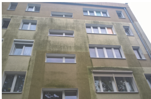
Rys. 5. Widok ściany wschodniej elewacji o ciemniejszej kolorystyce (archiwum autora)
