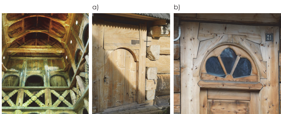
Rys. 7. Borgund, kościół z ok. 1150 roku – usztywnienie słupów nawy (fot. autor, 1998)
