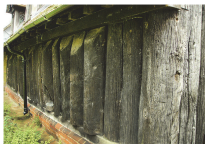
Rys. 3. Greenstead (Anglia – Essex), ściana kościoła z 845 r. (fot. autor, 1998)
