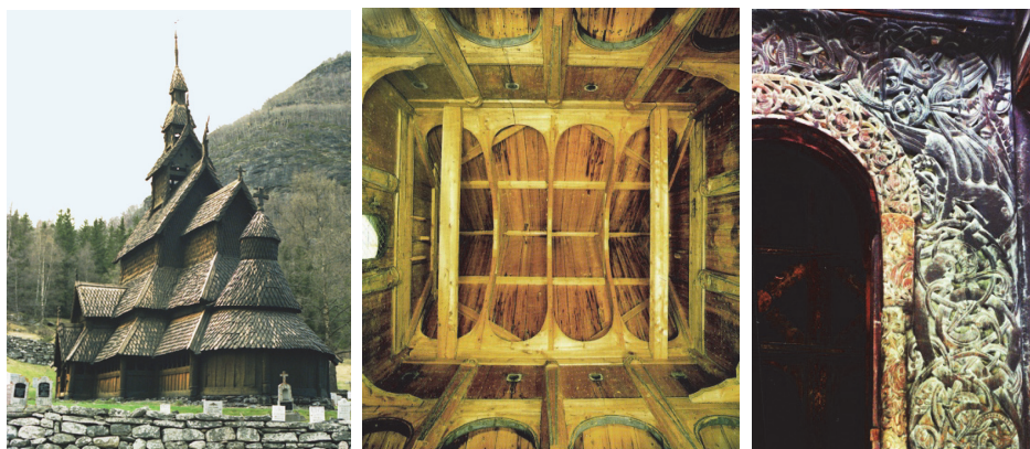
Rys. 12. Borgund – kościół z 1150 roku: widok, konstrukcja dachu nad nawą, detal portalu drzwi (fot. autor oraz [2] – środkowe)
