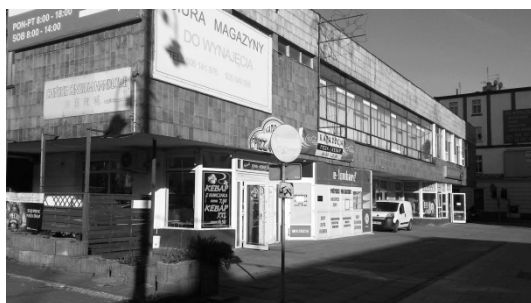
Rys. 5. Widok budynku przy ul. Dworcowej w Bydgoszczy, stan aktualny na sierpień 2017 roku (źródło: fot. M. Kaus, 2017)
