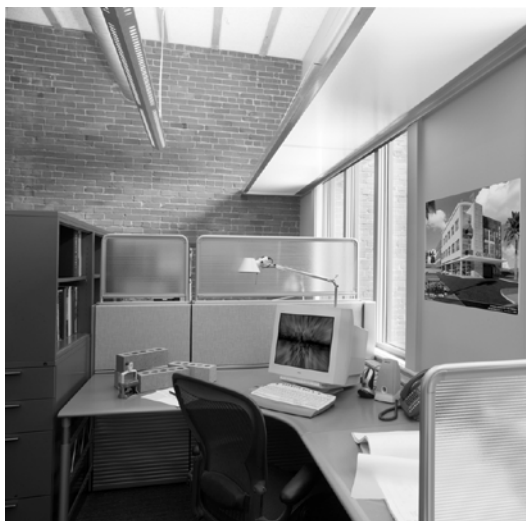
Rys. 2. Przezierna wewnętrzna półka świetlna mocowana do konstrukcji ściany osłonowej, jako element wnętrza uczestniczący w zmianie kierunku padania promieniowania słonecznego i jego transmisji w głąb pomieszczenia. Boulder Ass., Boulder, USA, architekt Boulder Ass., 2005, certyfikat LEED-CI poziom Gold (źródło: http://www.usgbc.org/projects/boulder-associates-offices (dostęp: 10.11.2015))
