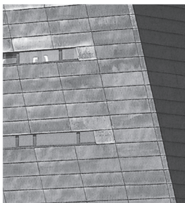
Rys. 5. Lisbon Harbour Control Tower . Miedziana elewacja uległa destrukcji powierzchniowej (fot. autora)
