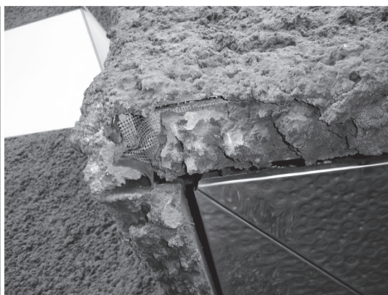
Rys. 6. Museu blau . Barcelona. Uszkodzenia narożnika tynku na elewacji (fot. autora)
