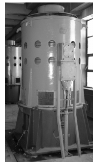
Rys. 2. Silnik elektryczny pompy diagonalnej
